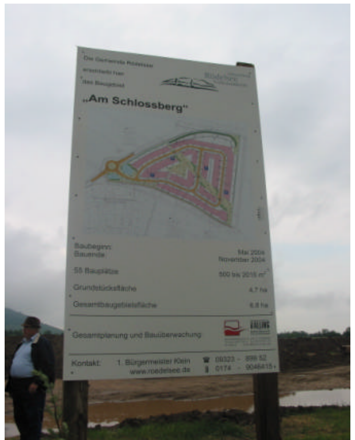
Bauschild für das neue Baugebiet
